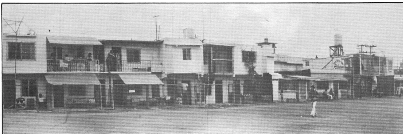
Fig. 3. Las construcciones "propiedad" de internos llamadas "carracas" son en algunos casos amplias y costosas.
